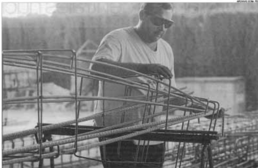
Un trabajador del Metal manipula una viga de hierro para encofrados en el sector de la construcción después de haber soldado las tiras
