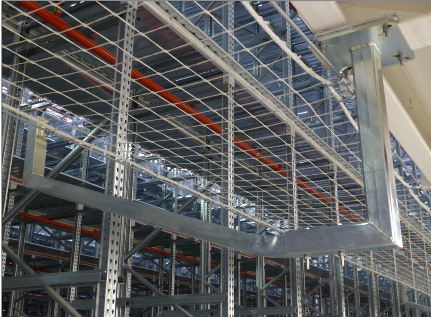
Anclaje de ménsulas mediante **sistema de pestañas**
