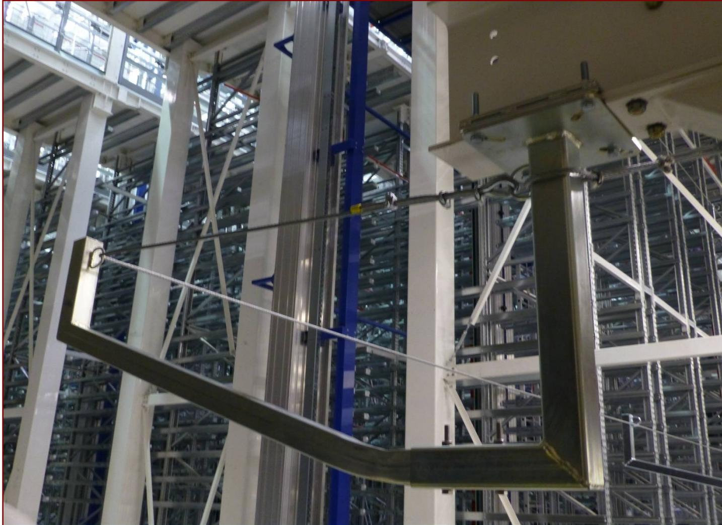
**Instalación: replanteo de cable para fijación de redes**
