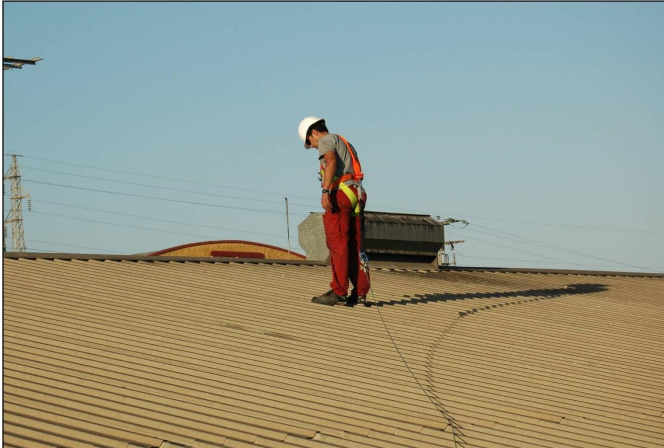
Acceso a cubierta con bloque anticaídas retráctil
