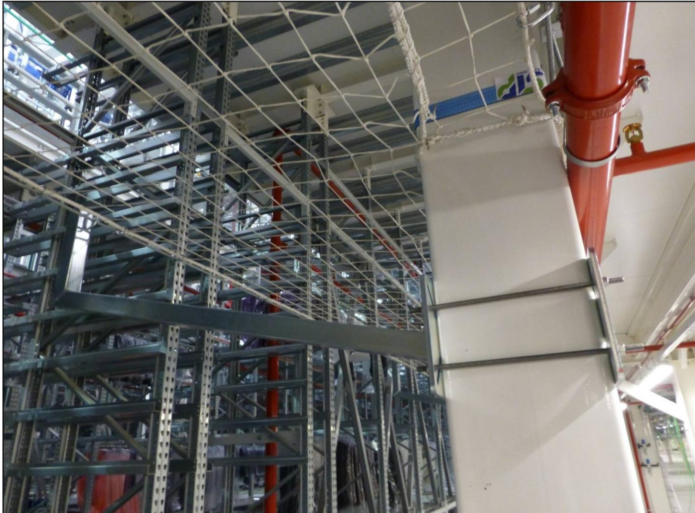
Anclaje de ménsulas mediante **sistema de abrazadera**
