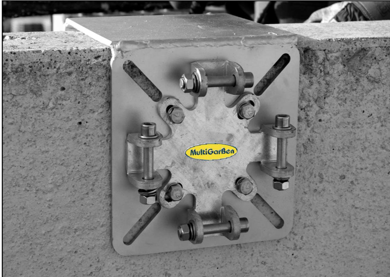
PLACA M02, dispositivo de anclaje en espera
