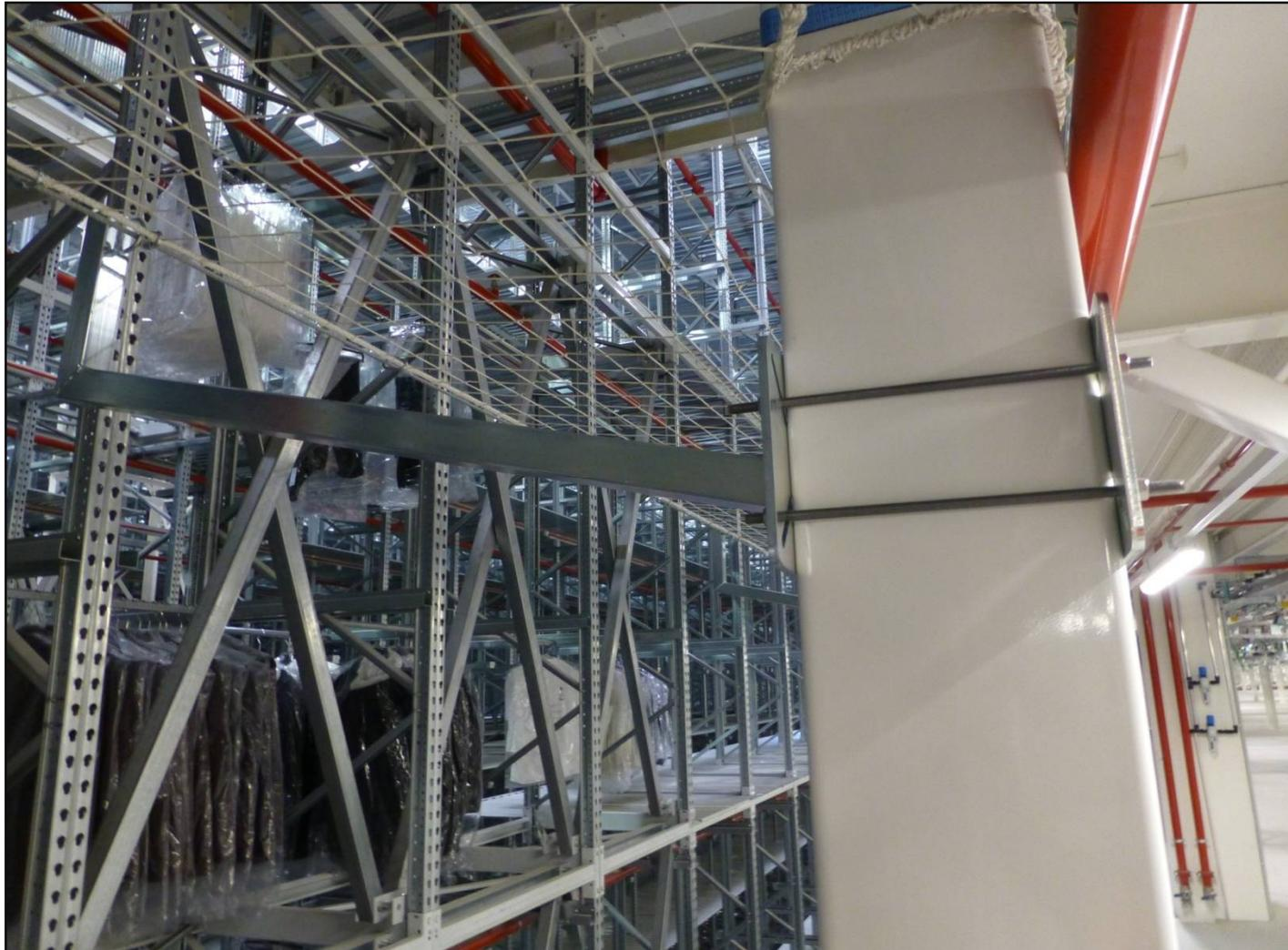
Anclaje de ménsulas mediante **sistema de abrazadera**
