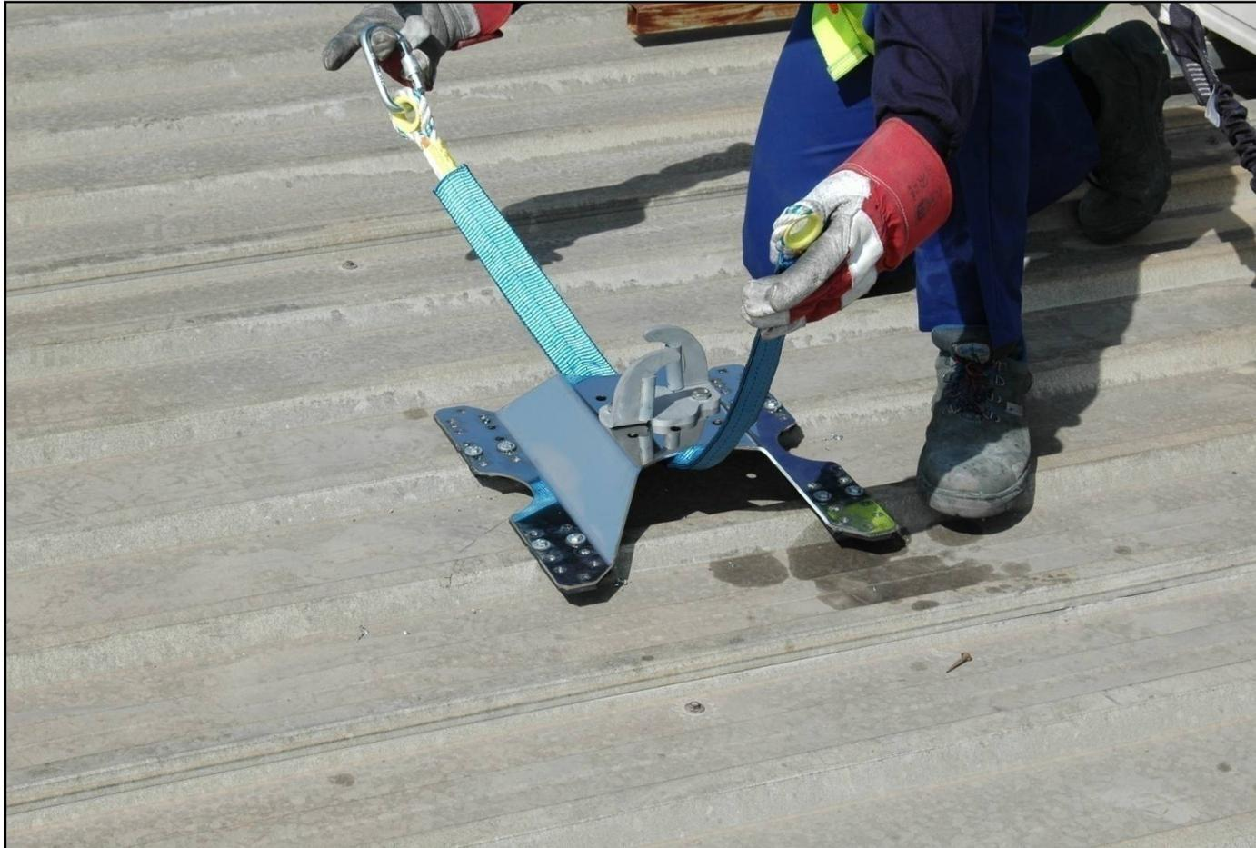
Proceso de instalación: abrazar el elemento resistente (2)
