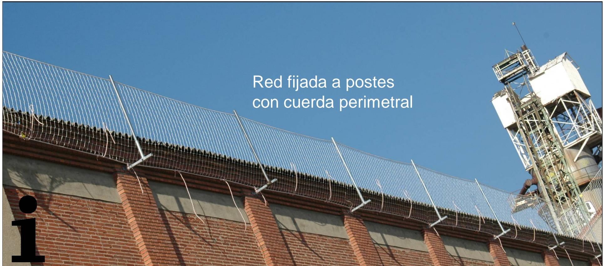
Postes anclados a pared mediante prolongador con varillas roscadas y resina
