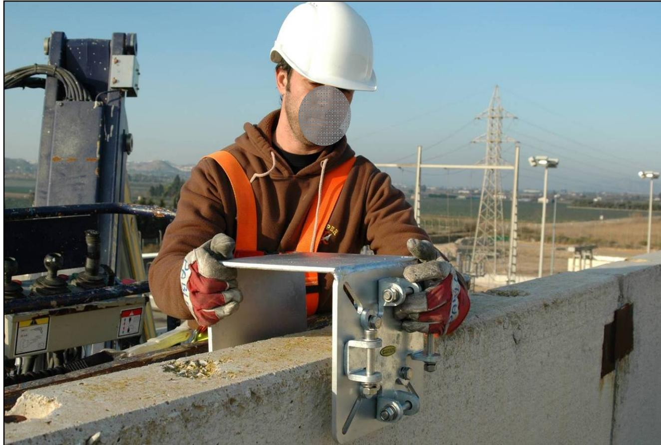
PLACA M02, dispositivo de anclaje para fijación en muros
