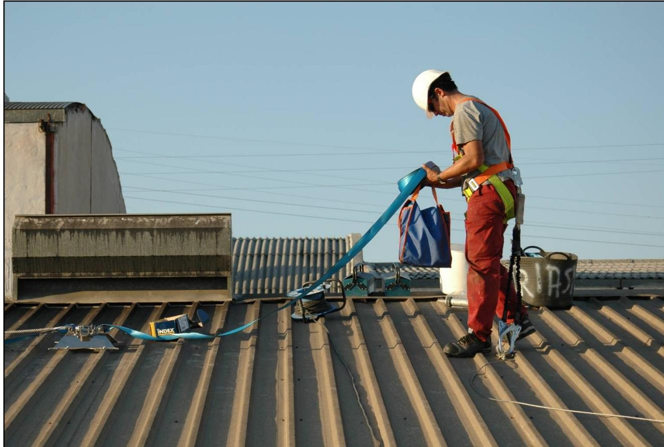
Utilización de líneas de anclaje para uso temporal: **rápida instalación**
