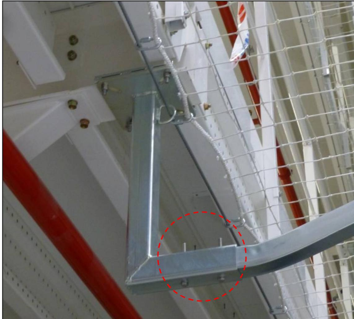
**No conformidad:** tornillos girados hacia la trayectoria de caída
