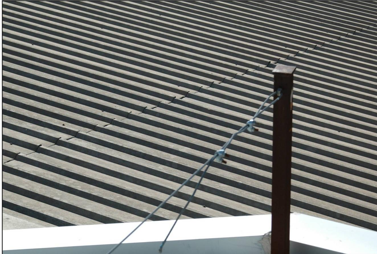
Líneas de anclaje utilizadas para el montaje/ mantenimiento de la cubierta
