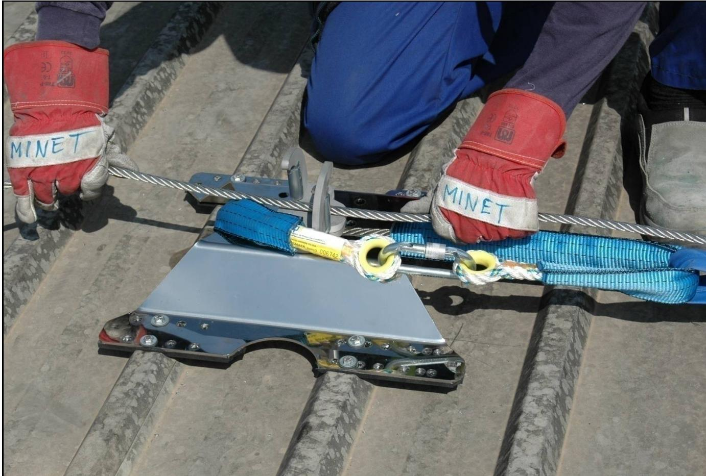
Instalación de cables de seguridad definitivos
