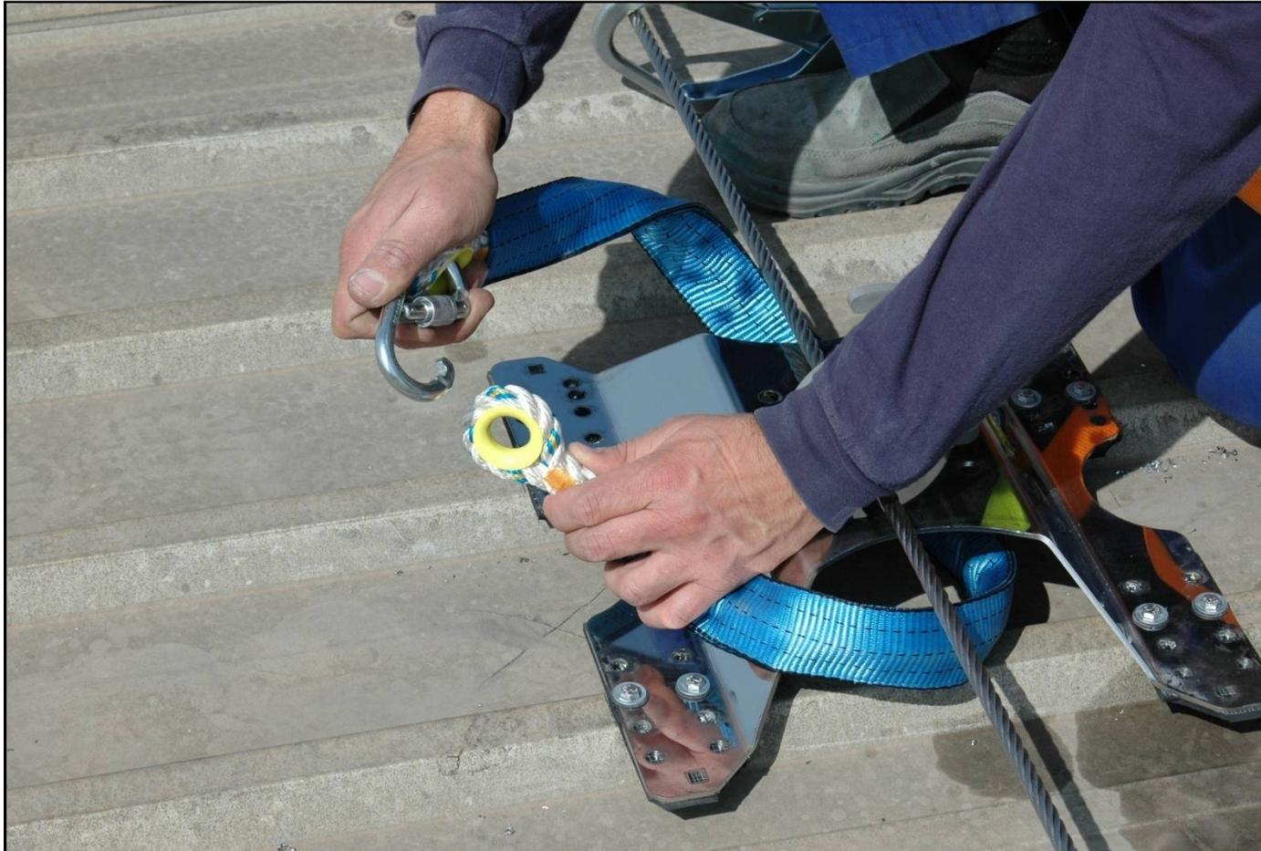
Proceso de instalación: unimos ambas gazas con el conector (3)
