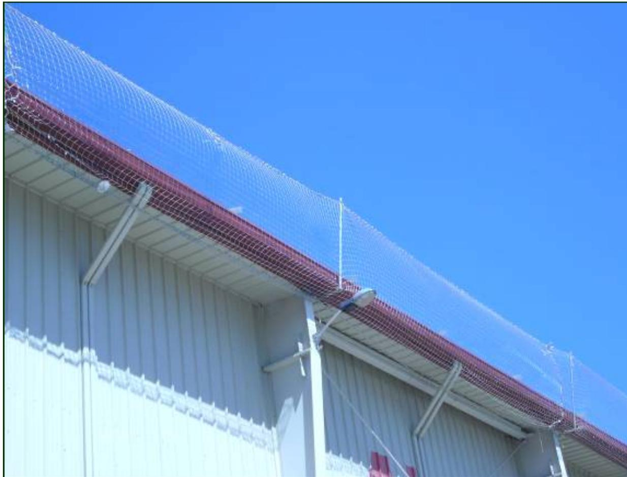
Postes anclados a vigas de acero mediante mordazas
