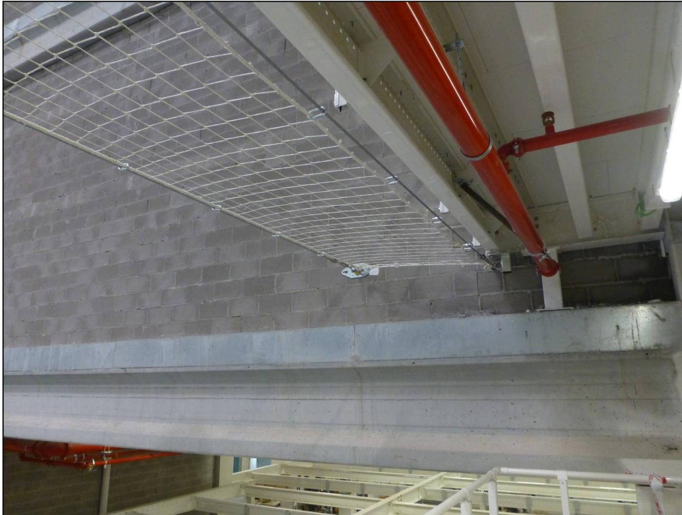
**Instalación:** anclaje terminal fijado a muro mediante placas especiales
