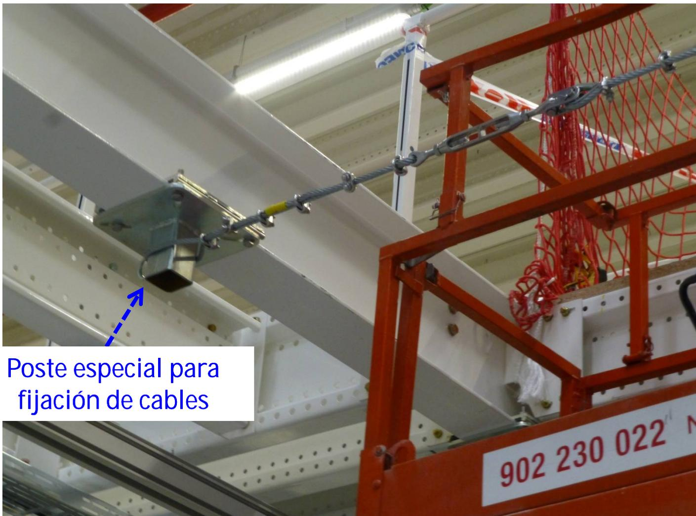
Replanteo: fijación de cables para fijación de redes
