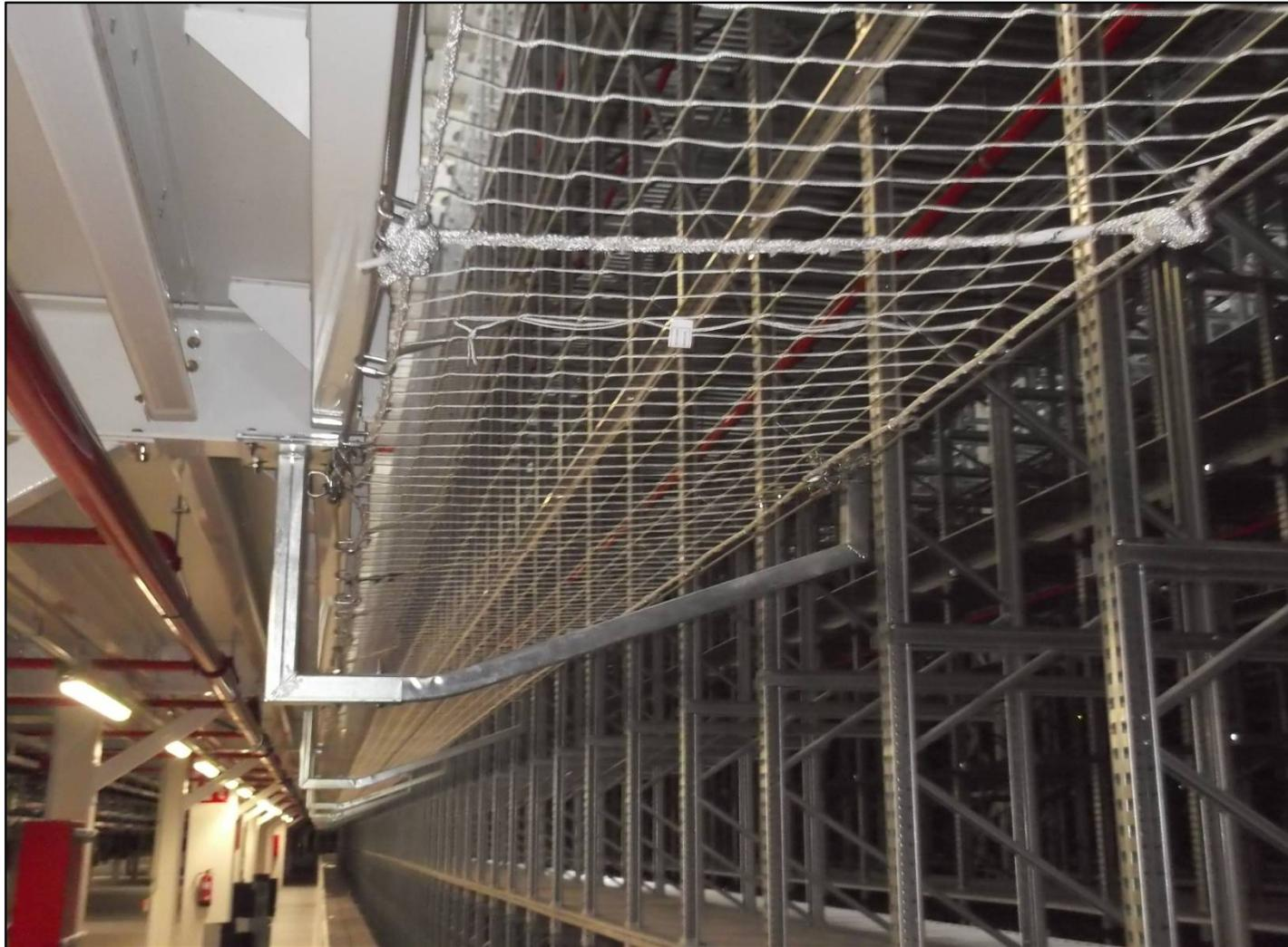
**Instalación:** unión de redes de seguridad (cuerda 0 – carga rotura 7,5 kN)
