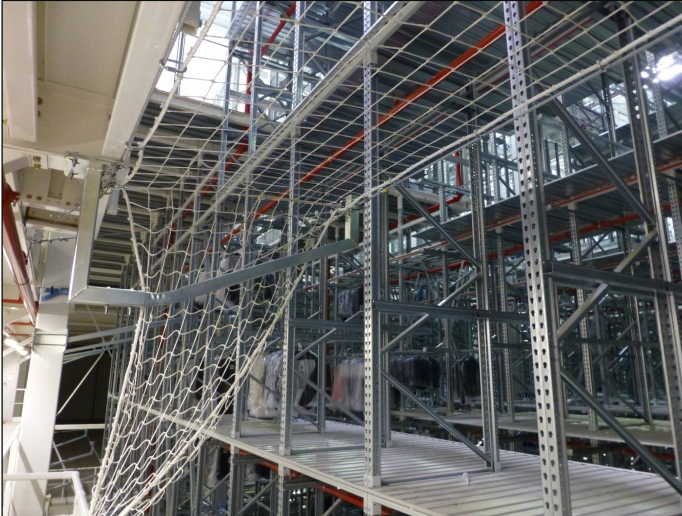
**Instalación:** anclaje de redes de seguridad
