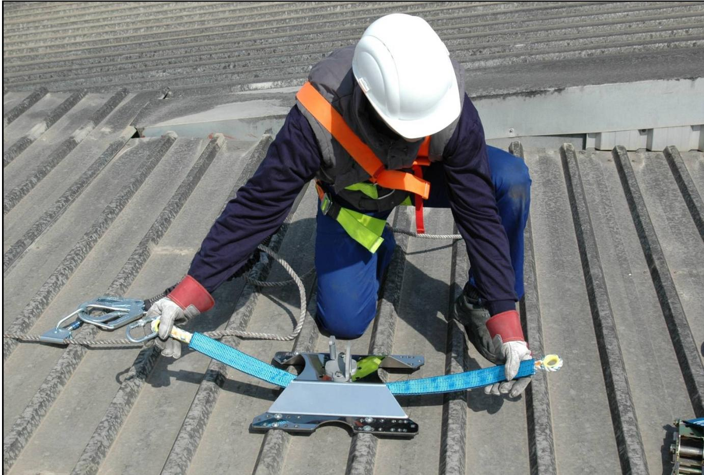
Proceso de instalación: abrazar el elemento resistente (1)
