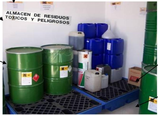
Sistema de recogida y detección de derrames o fugas: doble pared, bandeja anti-derrames, muro de confinamiento
