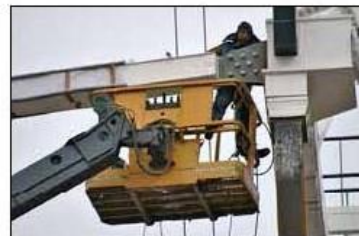
Figura 19. Operario subido sobre las barandillas.
