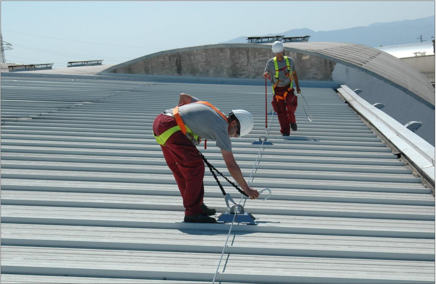
► Línea de anclaje fijada a chapa con postes abatibles
