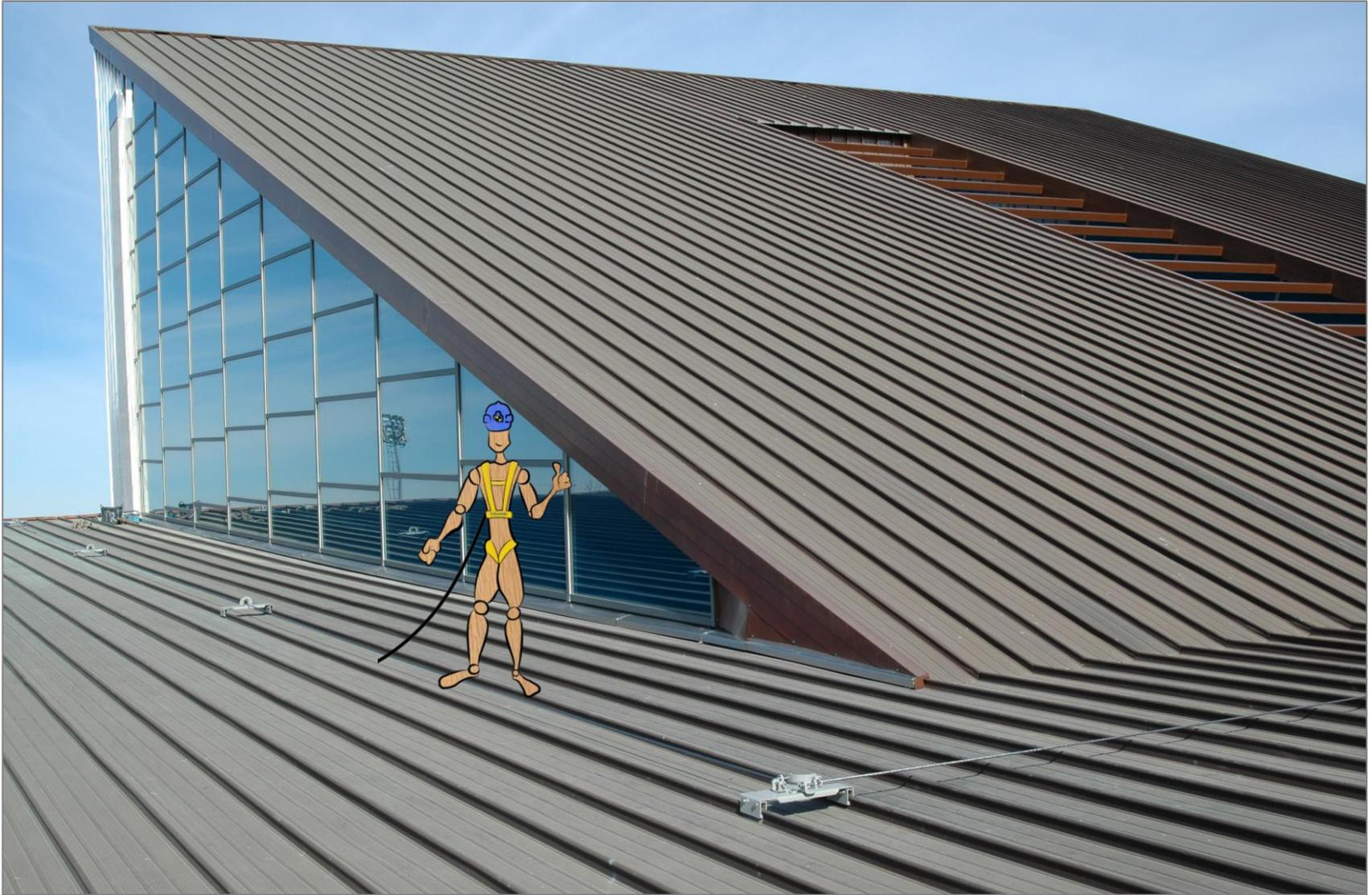
▶ Línea de anclaje fijada cubiertas de chapa (juntas de alzada)
