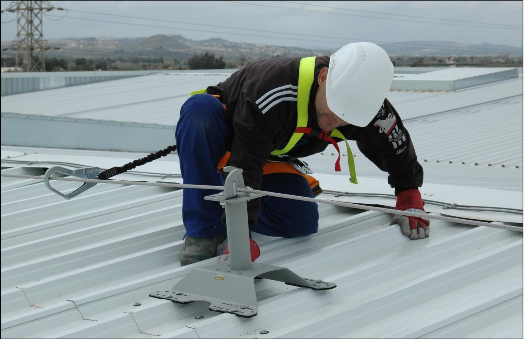
▶ Línea de anclaje fijada a cubierta minionda
