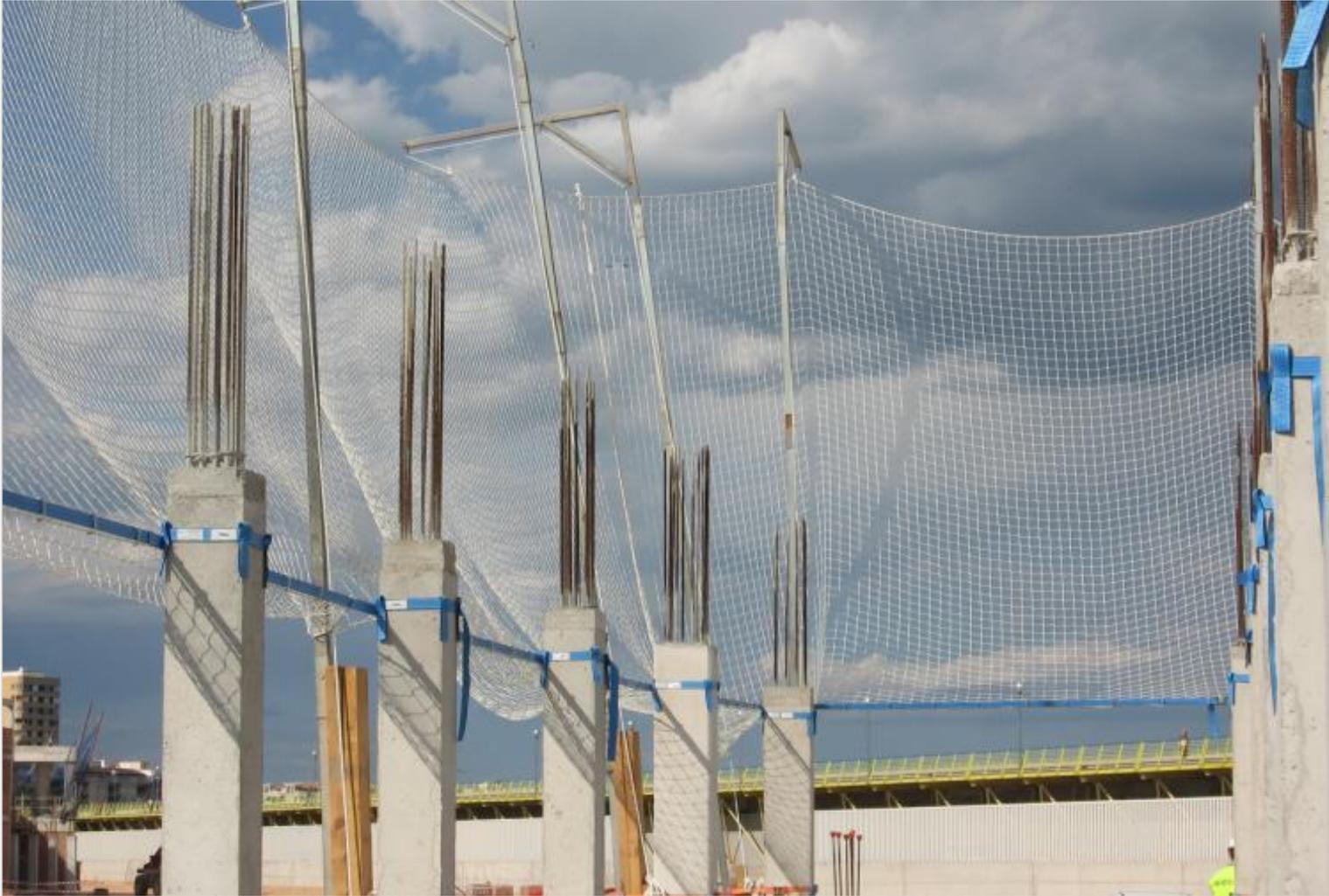
Instalación de redes de seguridad fijadas a cabeza de pilares
