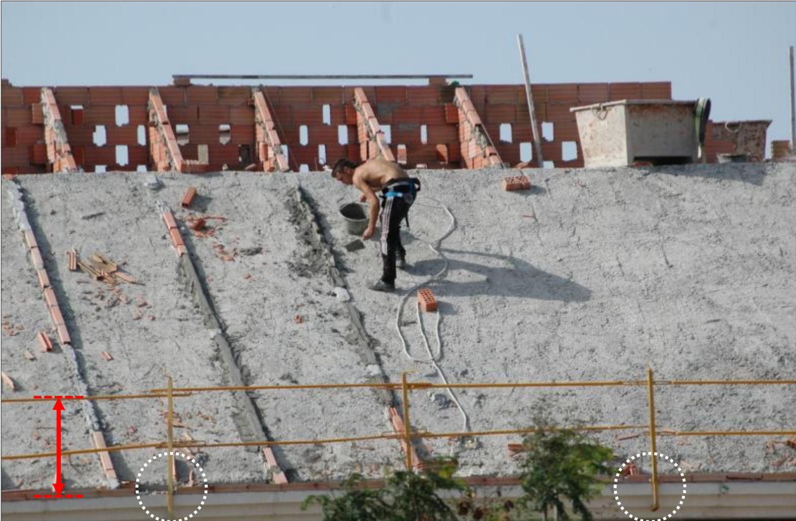
Desmontaje de barandillas previo a la instalación de teja
