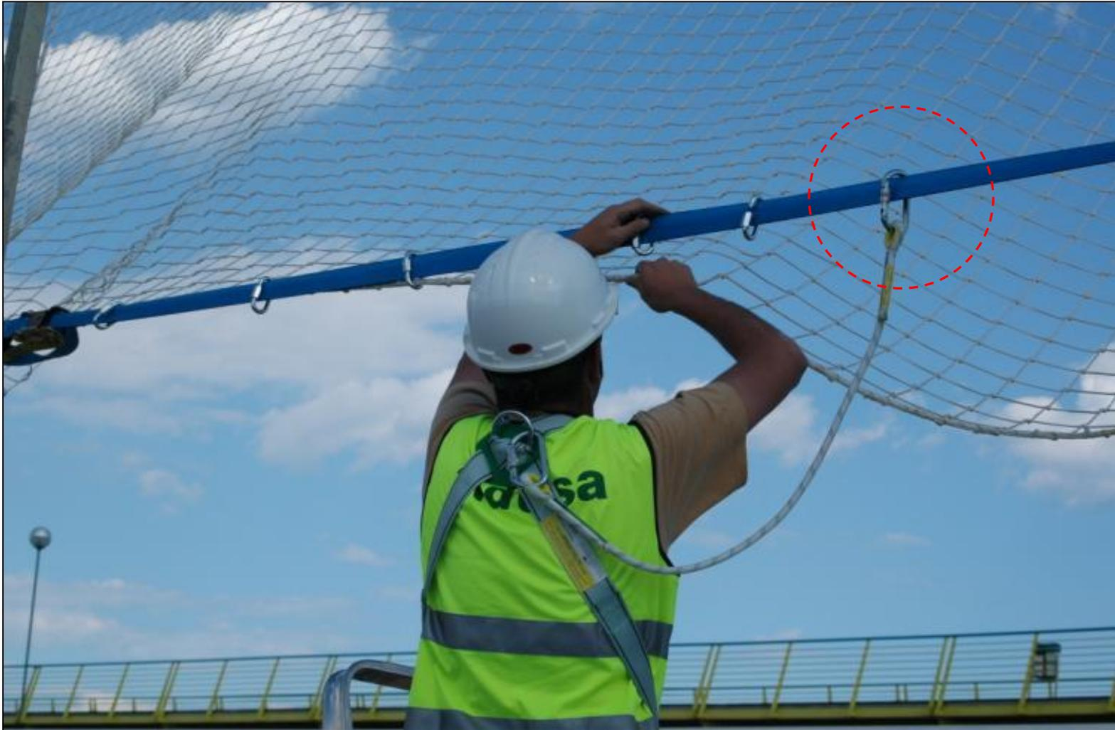
Anclaje de redes a líneas textiles mediante conectores con separación  $\leq 500$  mm
