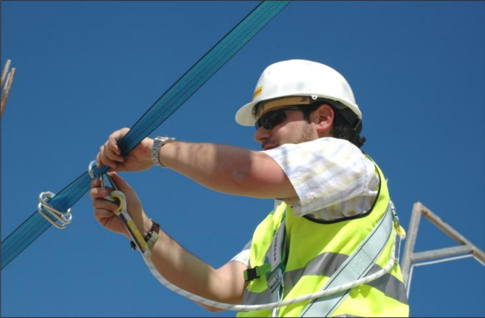
Fijación de conectores a líneas textiles para anclaje de redes
