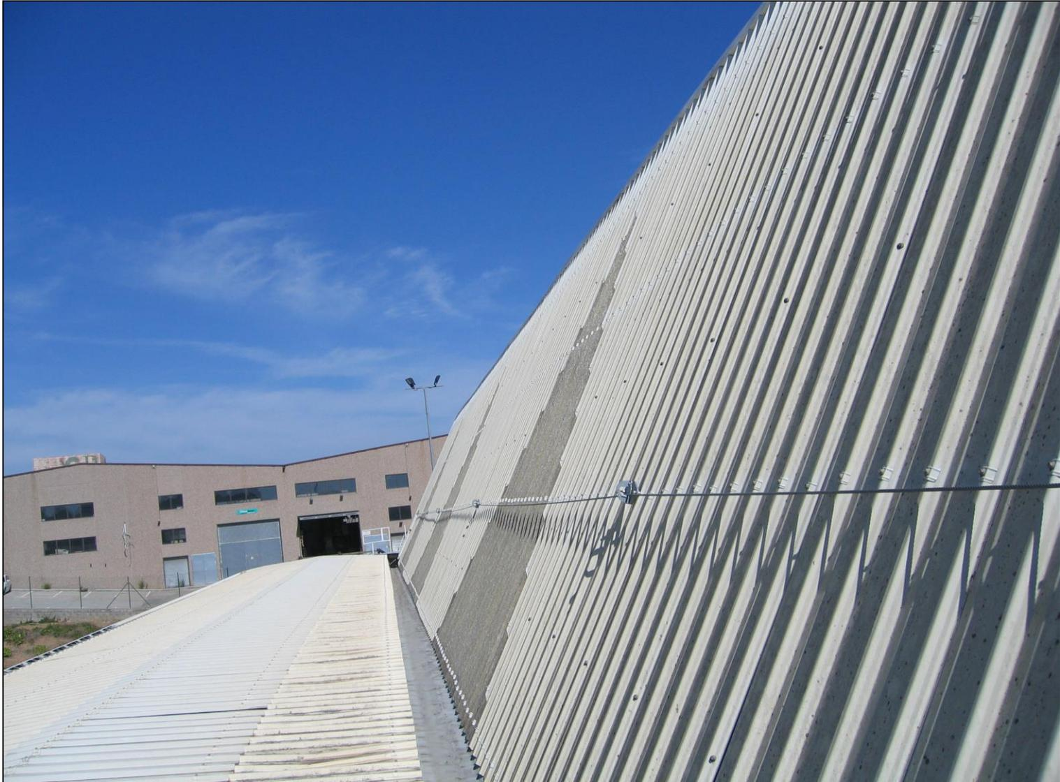
► Línea de anclaje fijada a panel tipo sandwich
