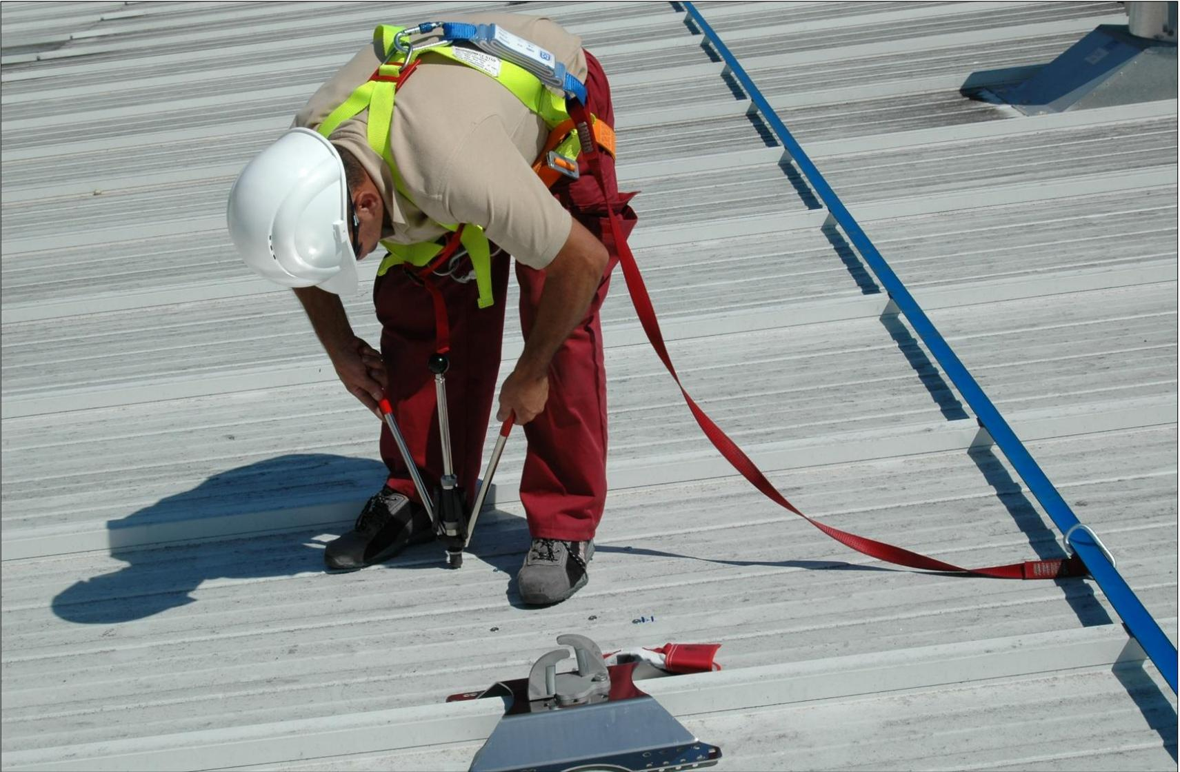
► Dispositivo de anclaje MultiGarBen para fijación de líneas textiles
