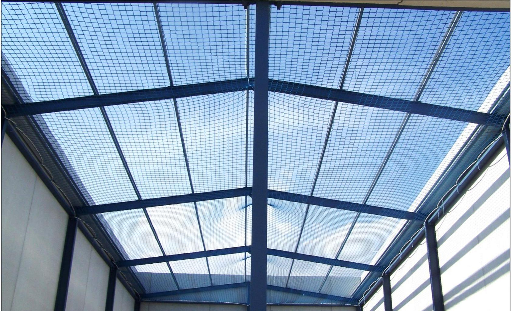
Cuerda perimetral  $\geq 30$  kN – dimensión  $\geq 35\text{m}^2$
