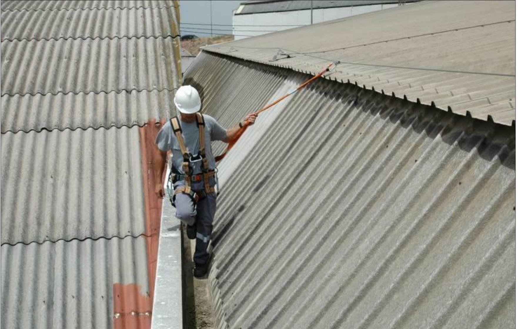
► Línea de anclaje fijada entre traslúcidas y borde del forjado
