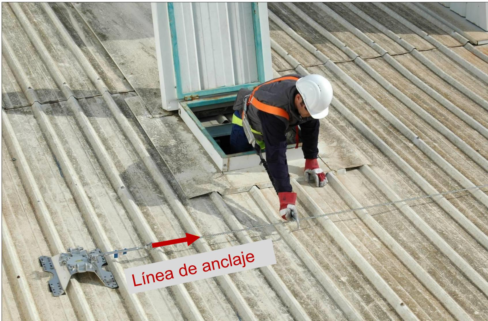
► Línea de anclaje fijada cubiertas de chapa (juntas de alzada)
