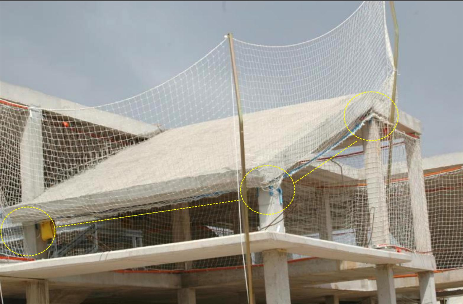
Construcción del 2º forjado con el sistema de seguridad previamente instalado
