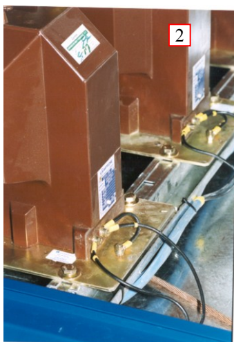
Placa de características y conexionado de los secundarios de los transformadores de medida. Los cables deberán ser apantallados (foto 1). La foto 2 muestra cables sin apantallar.
