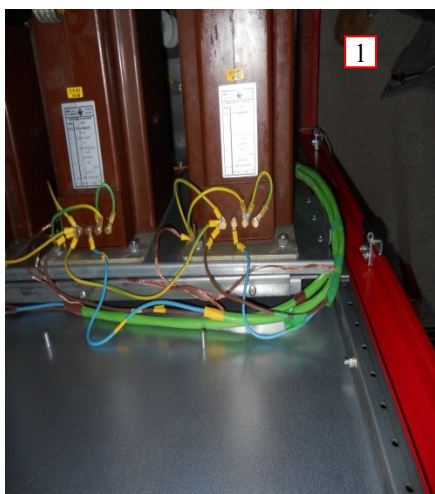
Placa de características y conexionado de los secundarios de los transformadores de medida. Los cables deberán ser apantallados (foto 1). La foto 2 muestra cables sin apantallar.
