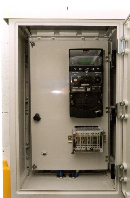
Módulo de Medida de dimensiones mínimas 750x500x300 mm de acuerdo a RPM según normas de Iberdrola. Se muestra sin todos los elementos a instalar
