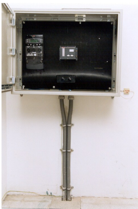
Módulo de Medida de dimensiones mínimas 750x850x300 mm de acuerdo a RPM según normas de Iberdrola. Se muestra sin todos los elementos a instalar
